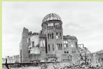
展示:広島県産業奨励館 東面 撮影:林 重男 提供:広島平和記念資料館
